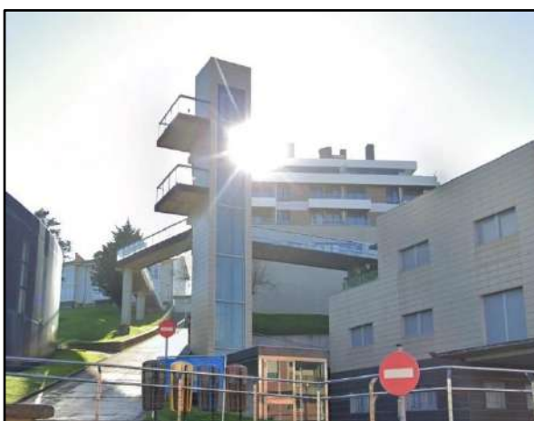
Imagen 2. Ascensor y pasarelas.
