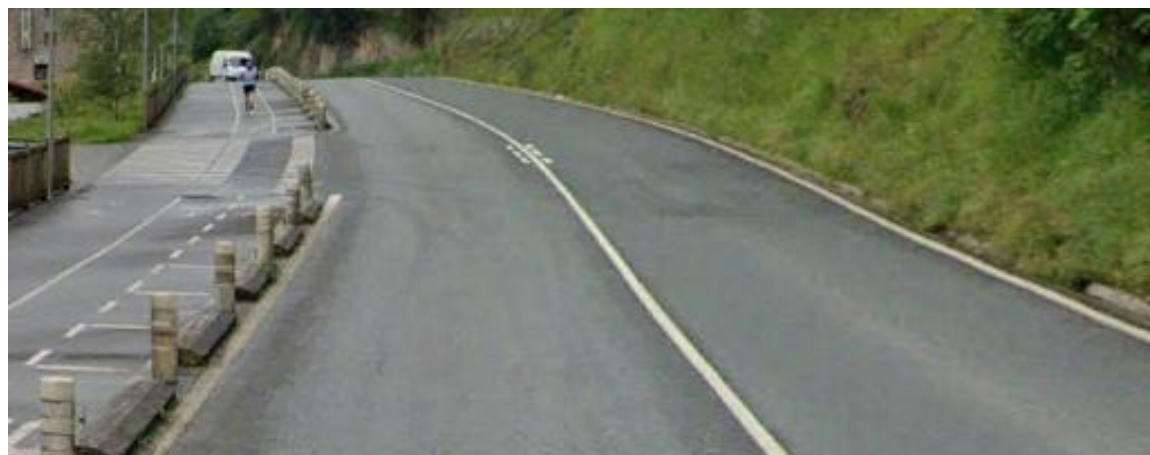
Bordillo moldagarriaren eta baliza zilindrikoaren kokapen-adibidea
