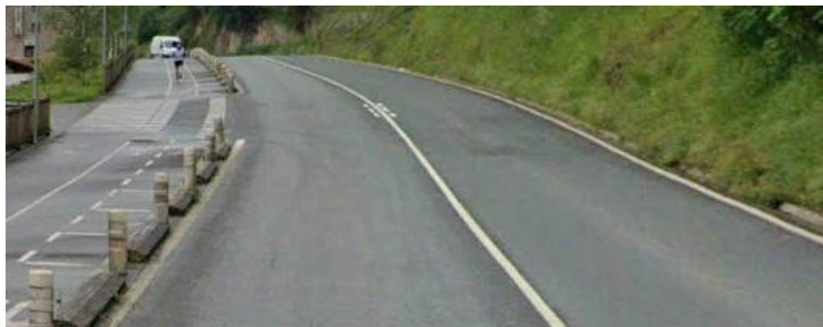
Ejemplo de disposición del bordillo montable y baliza cilíndrica
