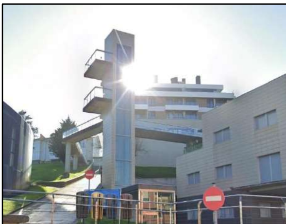
Imagen 2. Ascensor y pasarelas.
